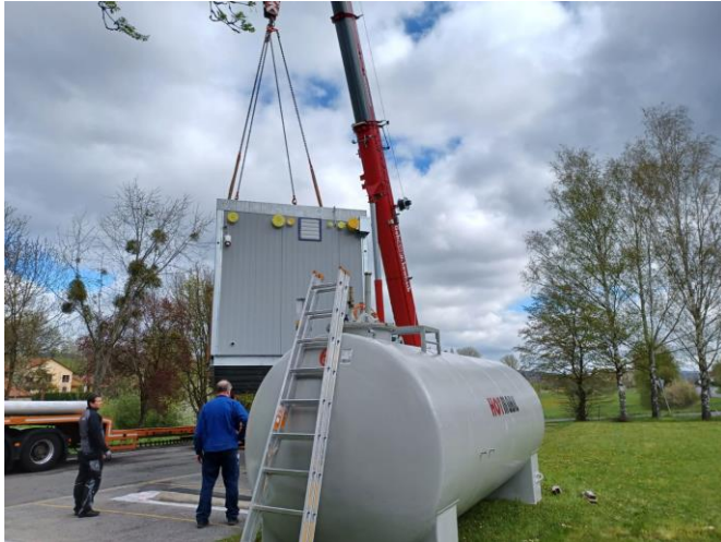
Mobiler Dampfcontainer wird mittels Krans abgeladen
